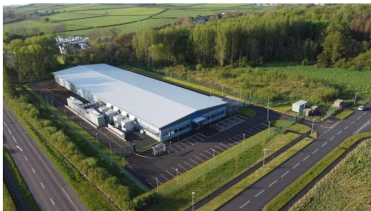
银在数据中心高效散热方面发挥着关键作用。
