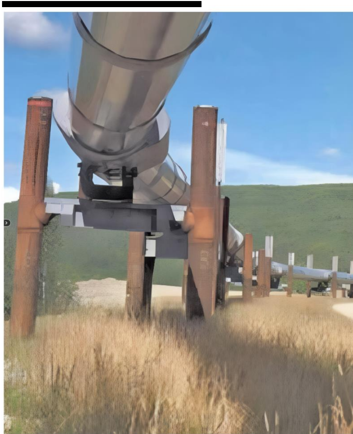
银合金有可能保护管道不发生腐蚀。
